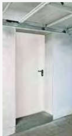
Stahl-Feuerschutztür H3-1 OD Dünnfalz mit Drückergarnitur
